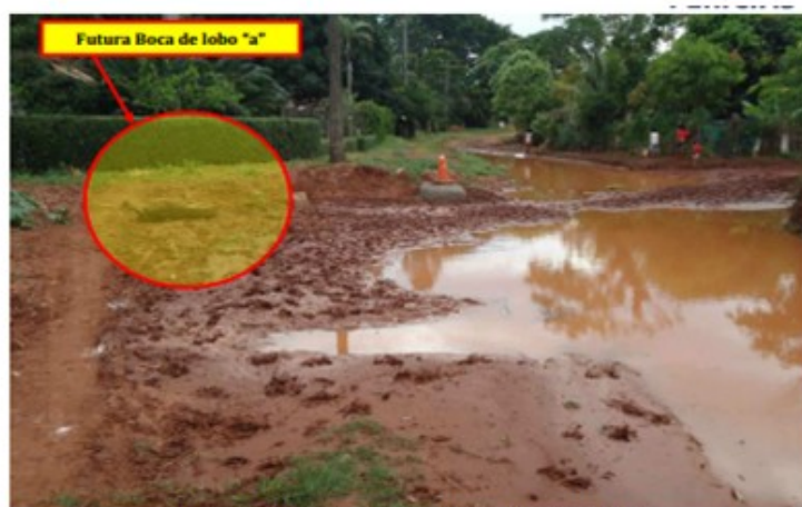
Situação antes da galeria, vista da futura boca de lobo "a"
