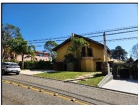
Vista da fachada da residência
