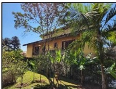
Fachada lateral do imóvel
