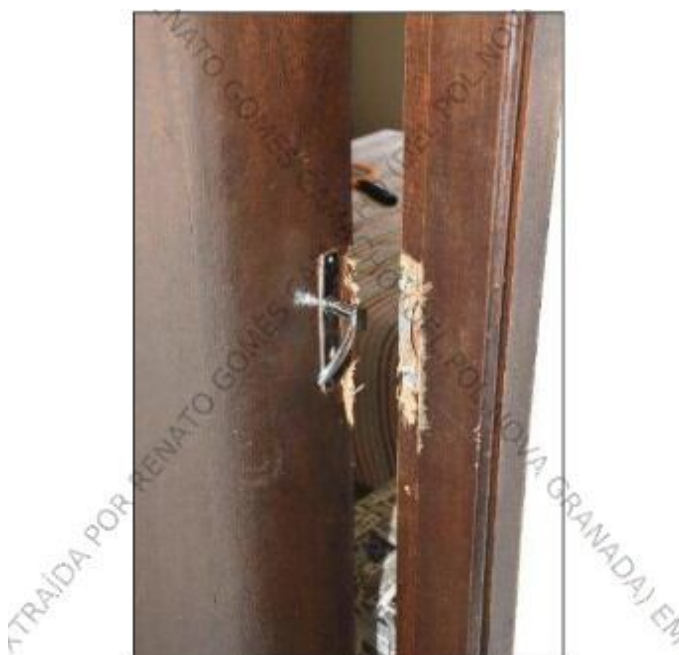
Figura 3. Detalhe dos vestígios de arrombamento da porta de vedação do quarto do casal.
